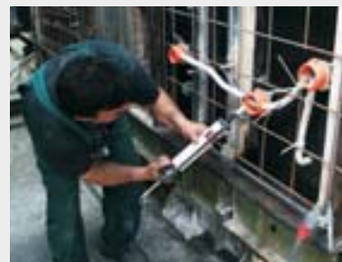
Герметизация вводов (отверстий).
