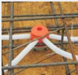
Пример установки в горизонтальной опалубке.
