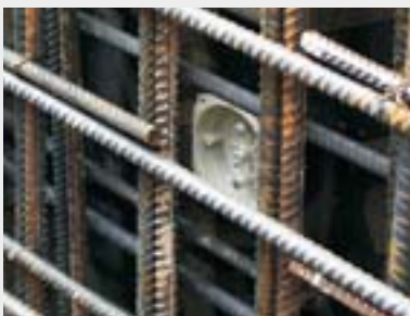
Крышка KBV, прикрепленная на опалубке.
