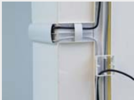
Установка кабель-каналов Элегант LE.
