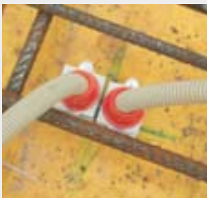
Пример использования концевых втулок и муфт.
