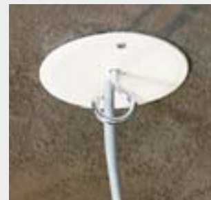
Коробка КВТ... закрытая крышкой V 68 S с выведенным проводом и люстровым крюком КВР...
