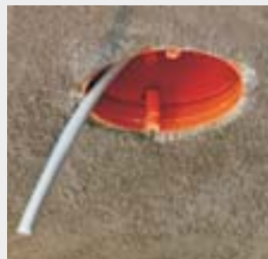
Коробка КВТ... с выведенным проводом, готова для установки люстрового крюка КВР...
